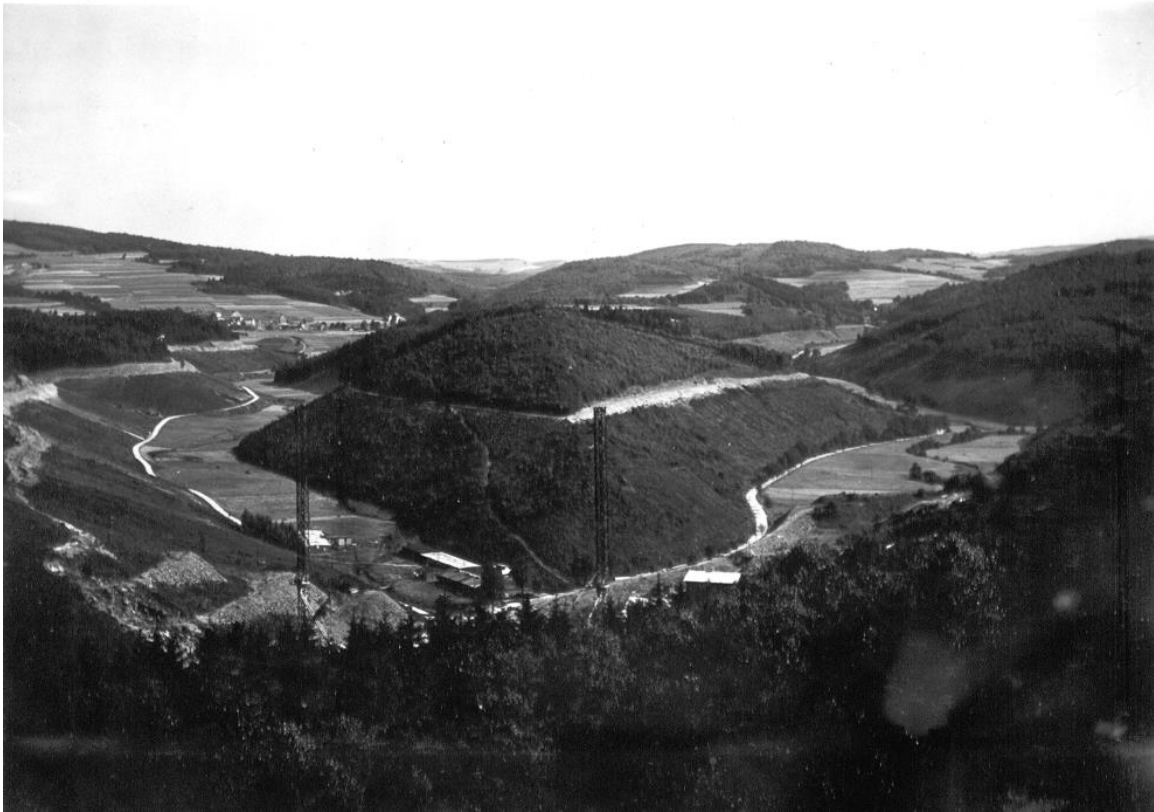
Blick vom Seuteschen Grundstück am Stockweg aus zum Burgkopf. Im Vordergrund die beiden Gießtürme 68 m hoch.
