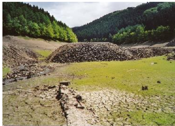
Staudamm des Reckhammers im Rengsetal
